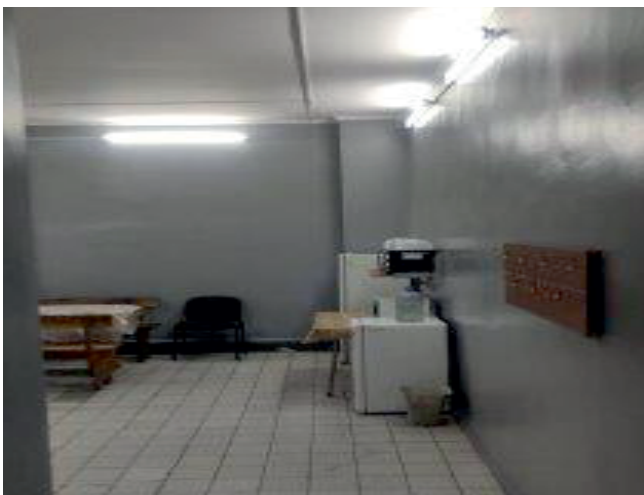
Капремонт комнаты приема пищи в здании депо
