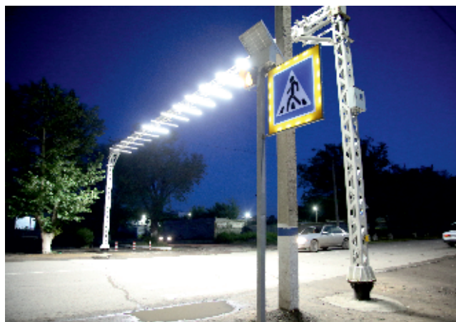
Установка воздушной зебры
