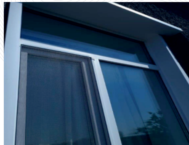
Замена пластиковых окон в здании поста ЭЦ, ст. Трудовая
