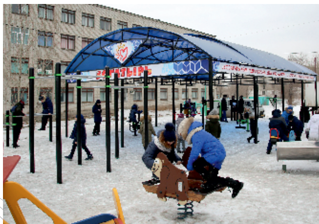
Установка воркаут площадки
