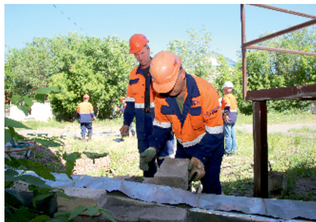
Ремонт системы водоснабжения городской мечети
