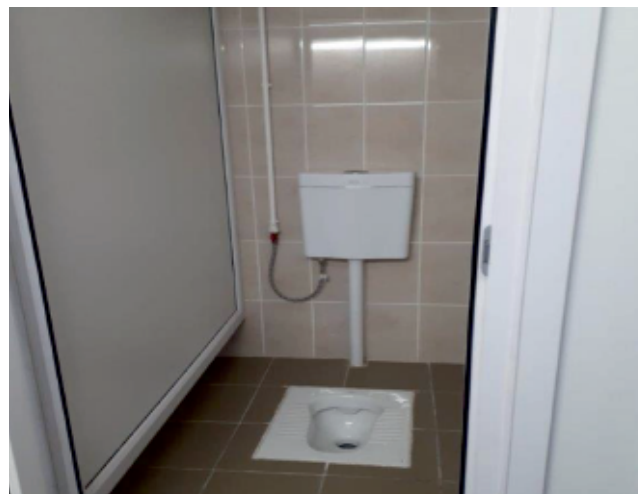
Ремонт мужского туалета. РГТО
