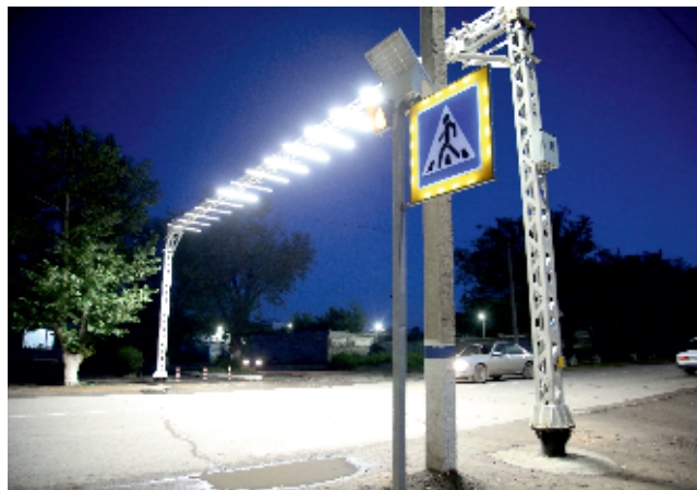
Установка воздушной зебры
