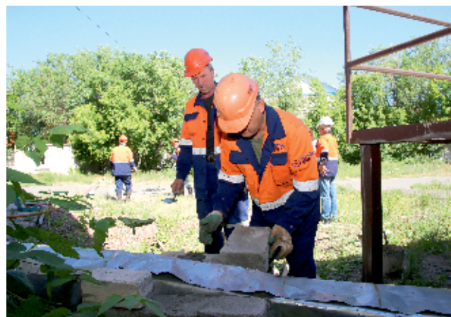
Ремонт системы водоснабжения городской мечети
