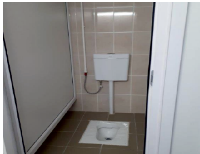
Ремонт мужского туалета. РГТО
